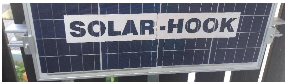
Abb. 12/Modulendklemme anbringen rechts und links
