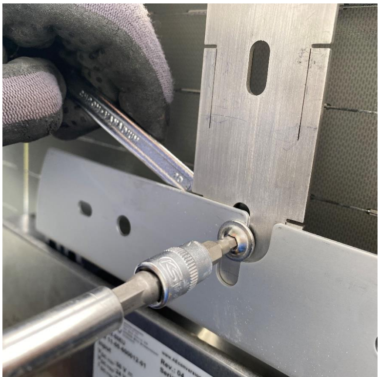
Abb. 6/Wechselrichter am SOLAR-HOOK Befestigungsbügel anschrauben
